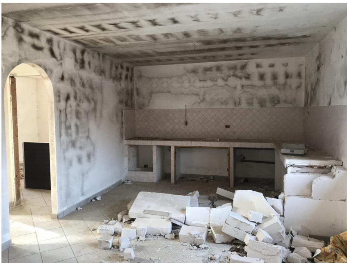
FOTO N° 20 –Vista interna U.I. Sub 10
