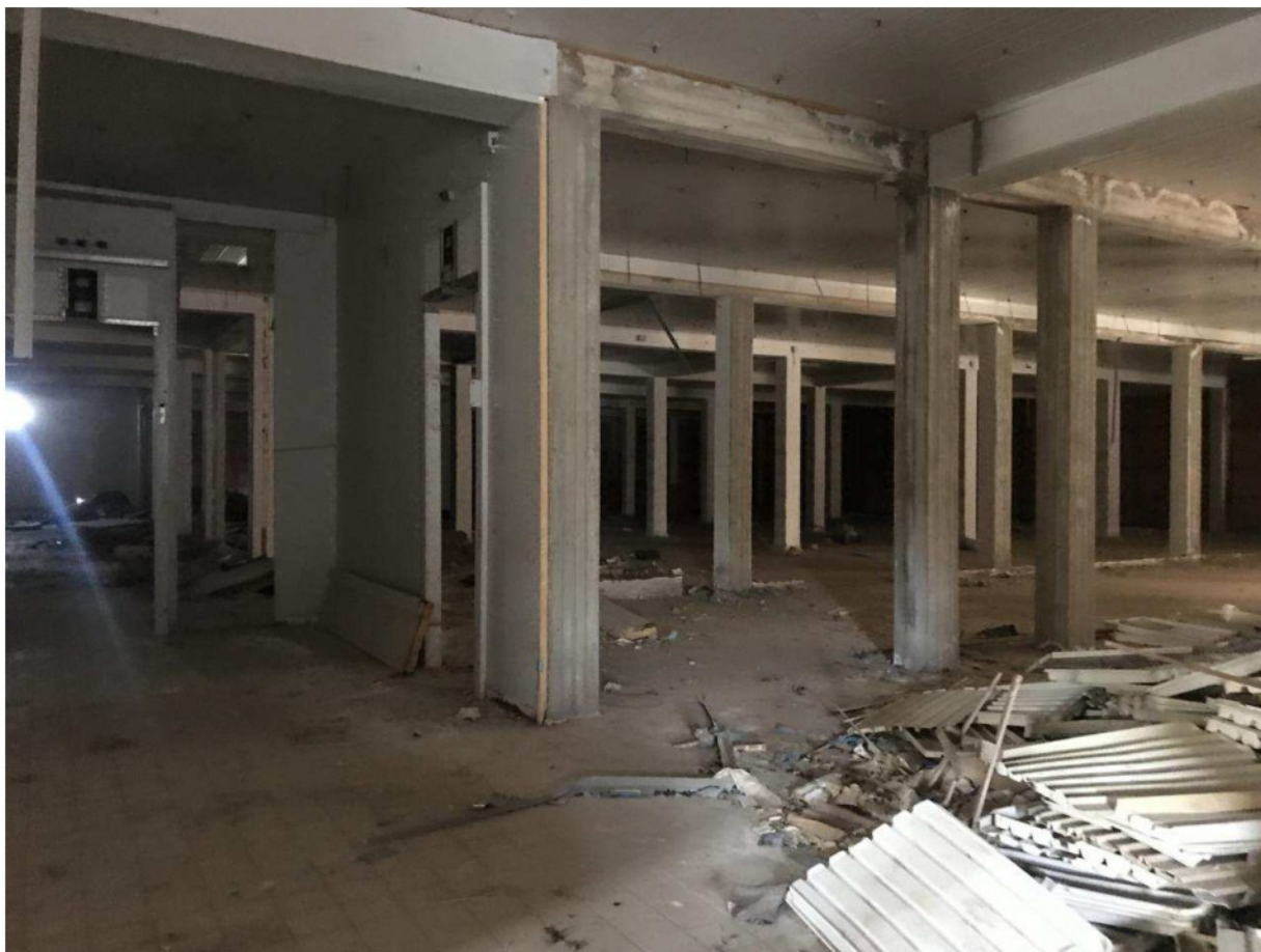
FOTO N° 11 –Vista interna Piano terra U.I. Sub 3
