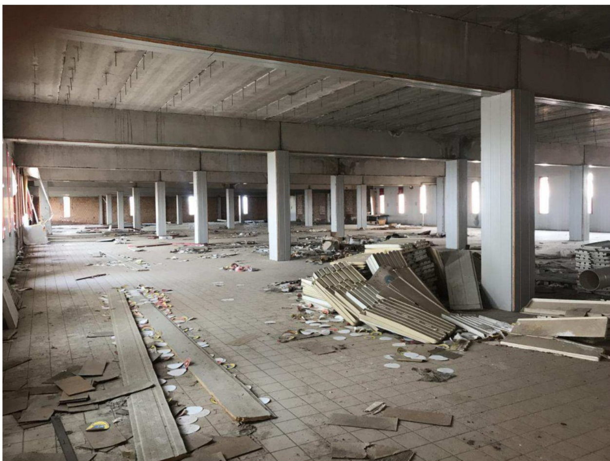
FOTO N° 10 –Vista interna Piano primo U.I. Sub 2
