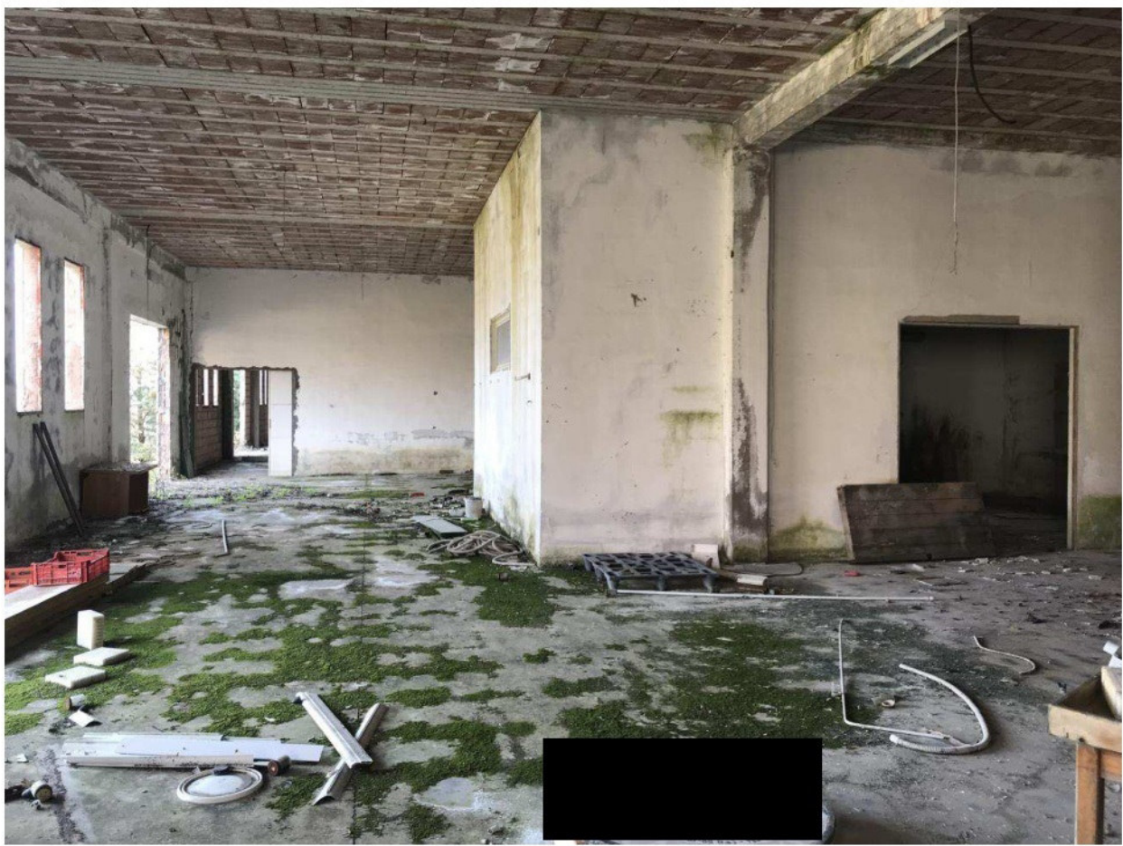
FOTO N° 16 –Vista interna U.I. Sub 5
