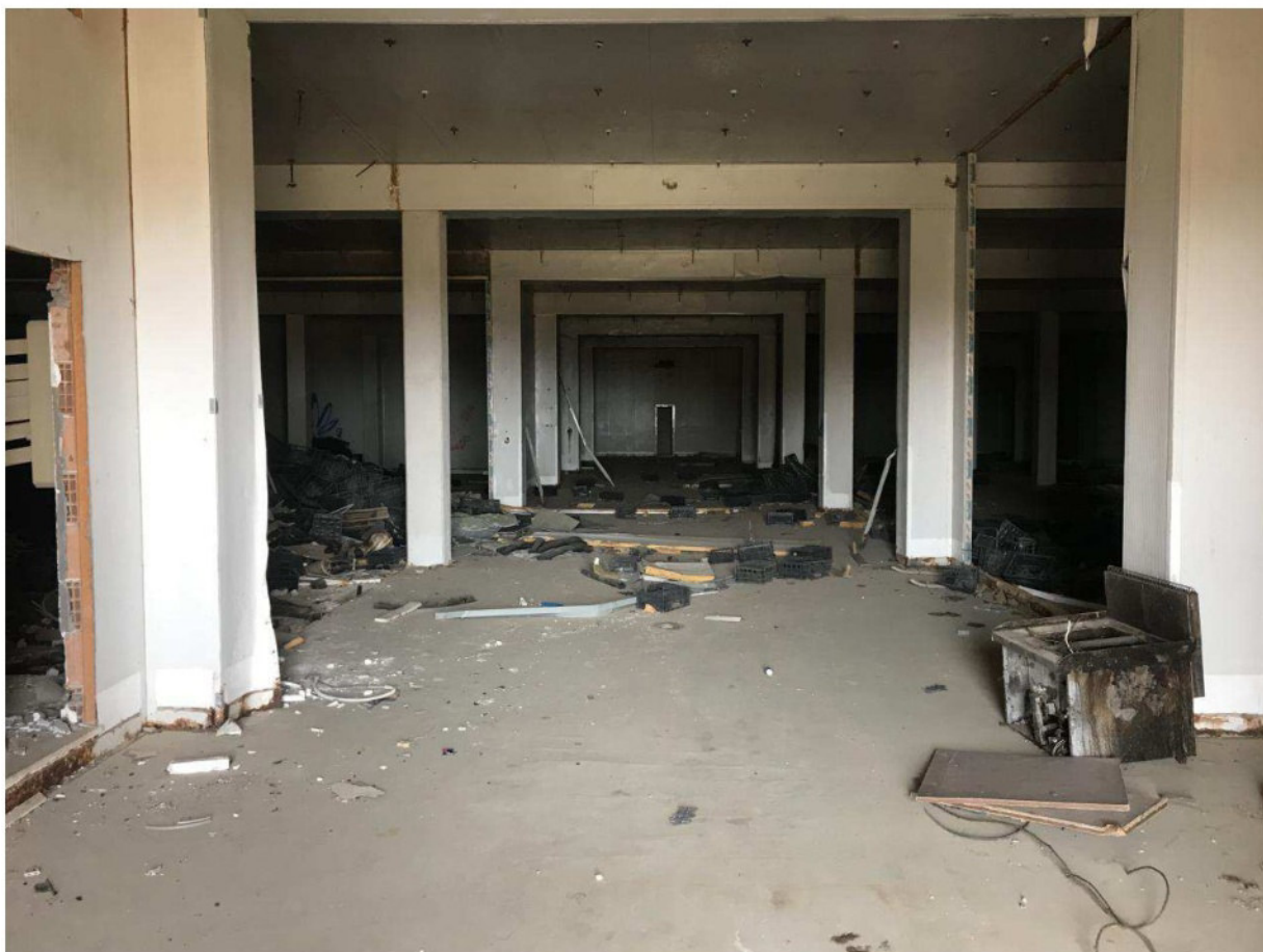
FOTO N° 13 –Vista interna Piano seminterrato U.I. Sub 2
