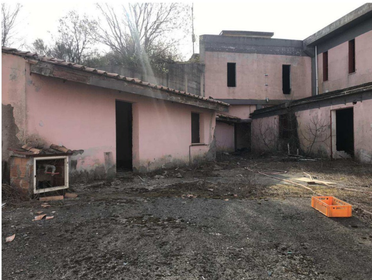
FOTO N° 5-6 –Veduta esterna dal piazzale inferiore Fabbricato U.I. Sub2
