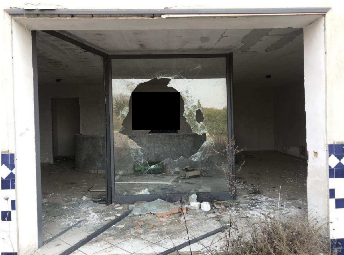
FOTO N° 18 –Vista interna piano seminterrato U.I. Sub 9
