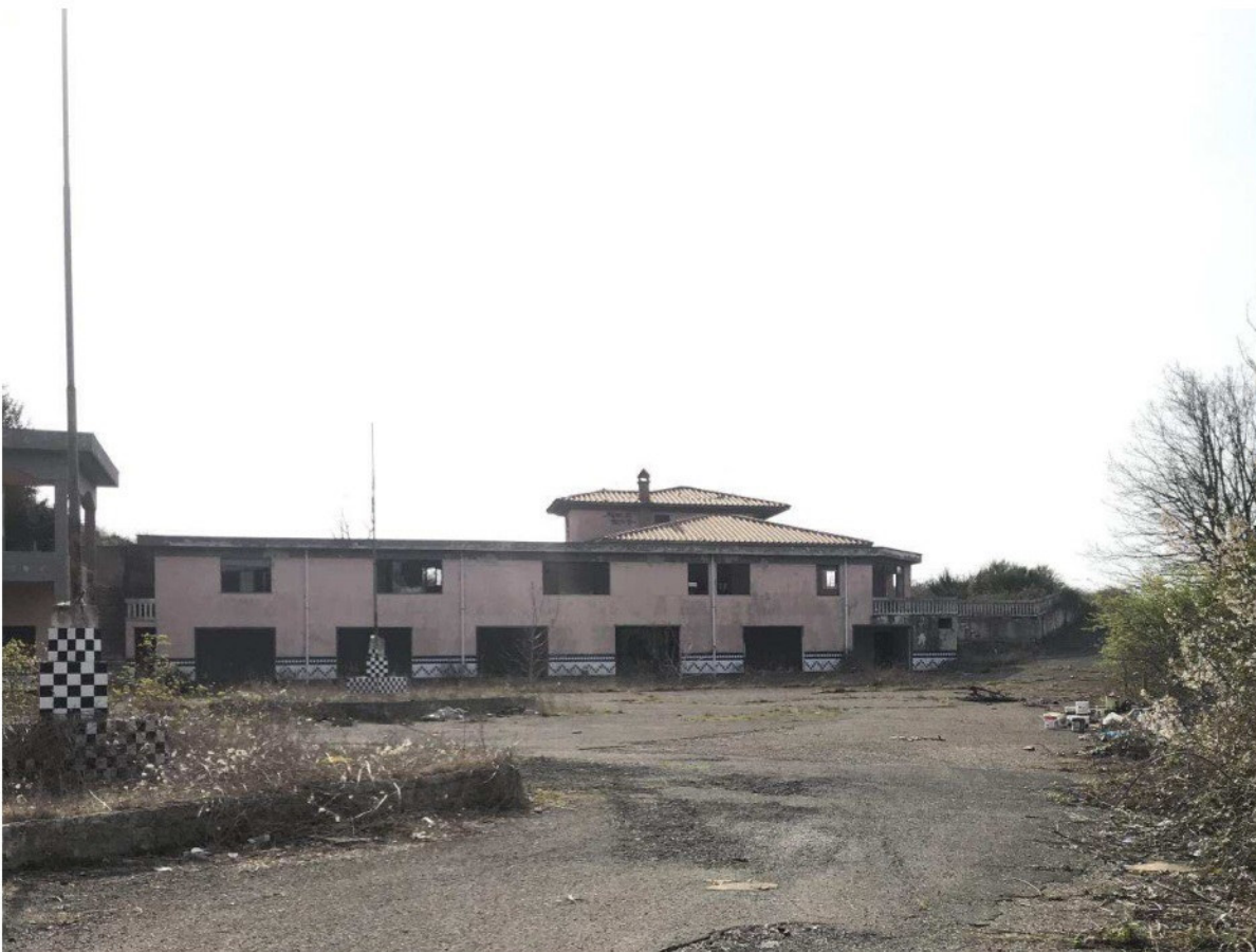
FOTO N° 2 – veduta esterna Fabbricato U.I. Sub 7/8/9/10
