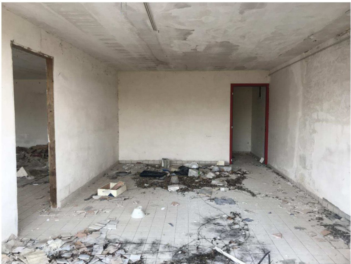
FOTO N° 15 –Vista interna U.I. Sub 7
