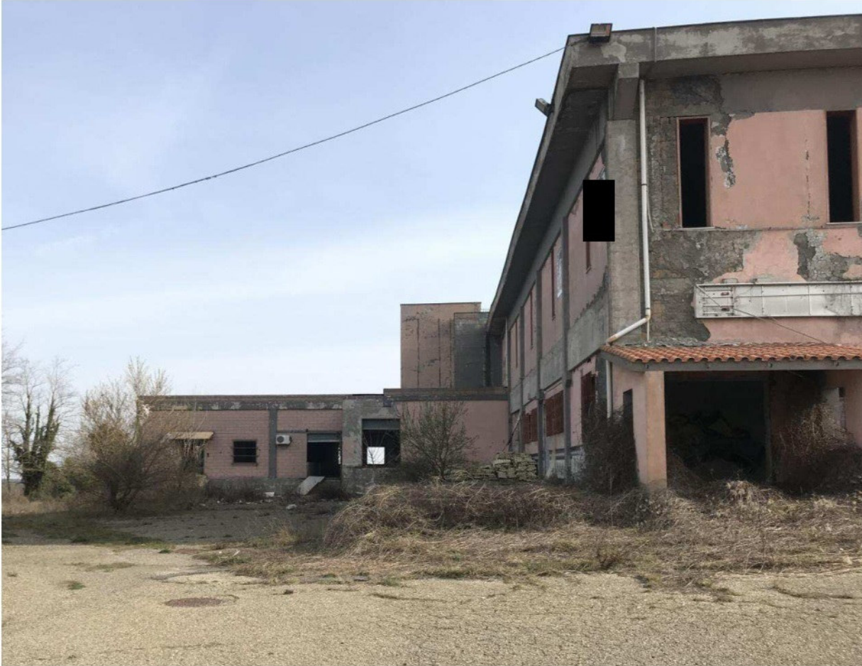
FOTO N° 3 – Veduta esterna Fabbricato U.I. Sub 4
