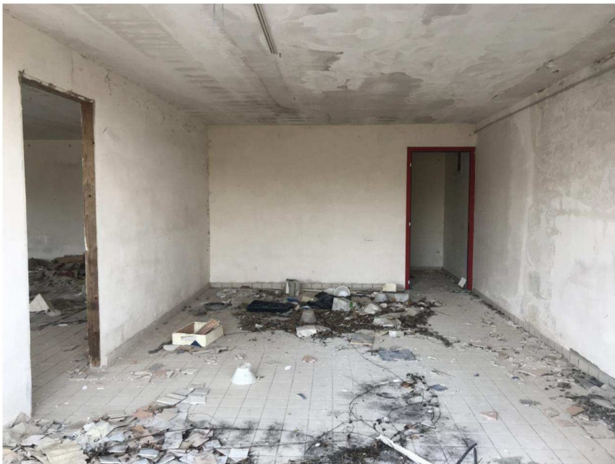
FOTO N° 17 –Vista interna U.I. Sub 7
