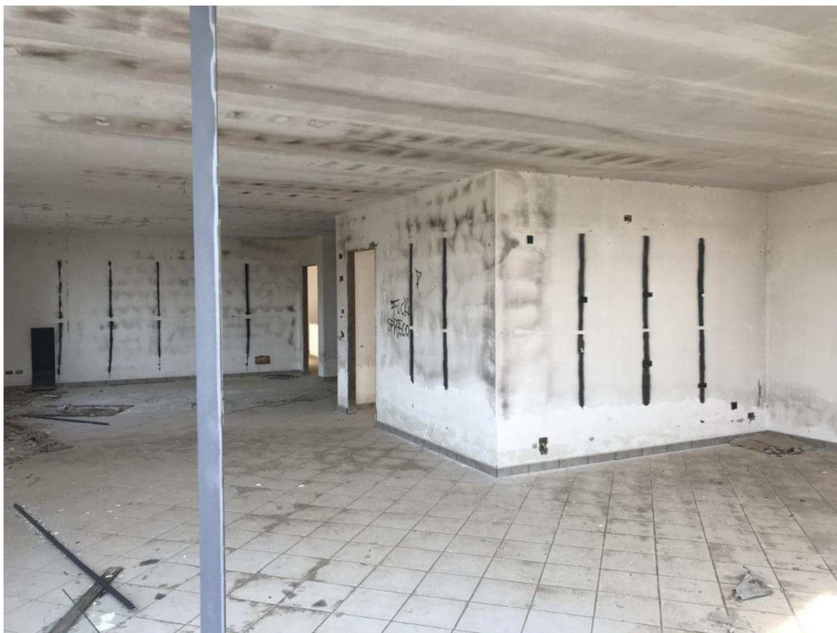
FOTO N° 19 –Vista interna piano primo U.I. Sub 9
