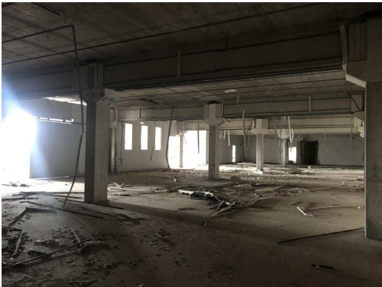
FOTO N° 9 –Vista interna Piano terra U.I. Sub 2
