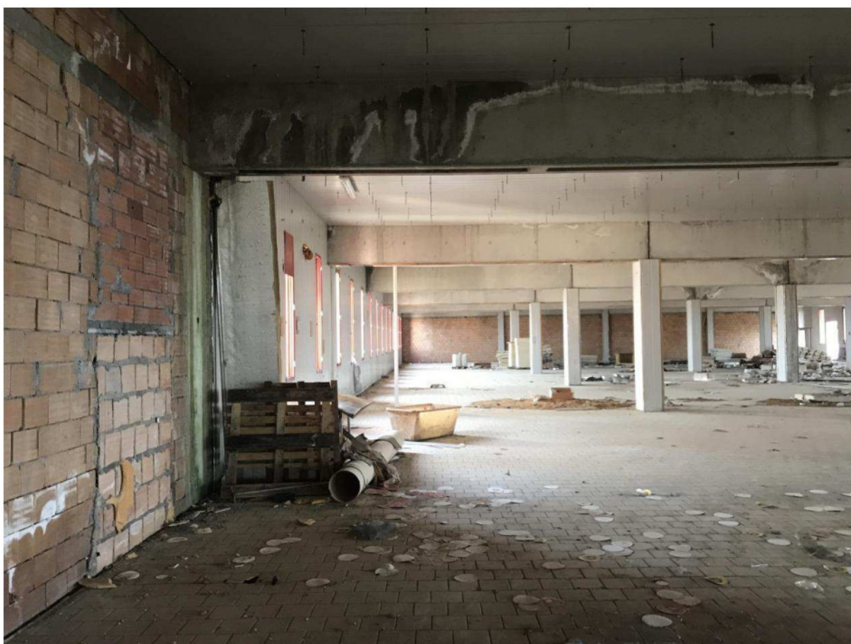
FOTO N° 12 –Vista interna Piano primo U.I. Sub 3
