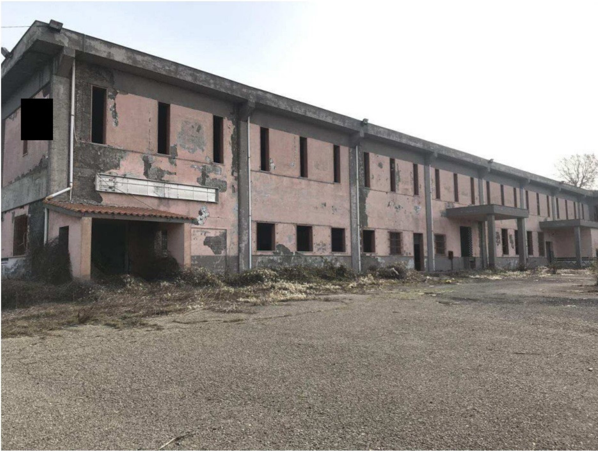
FOTO N° 1: Veduta dal Piazzale Fabbricato U.I. Sub 2
