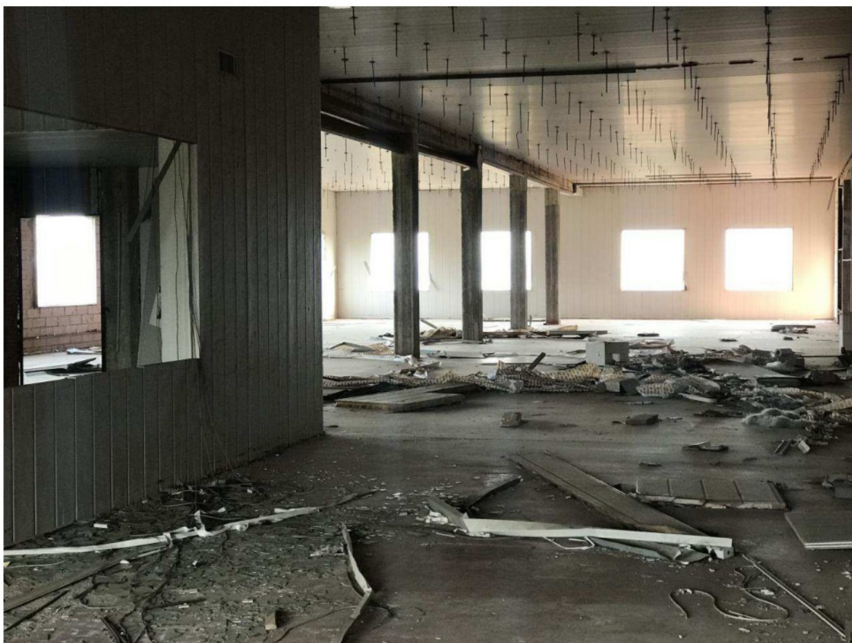
FOTO N° 14 –Vista interna Piano terra U.I. Sub 4
